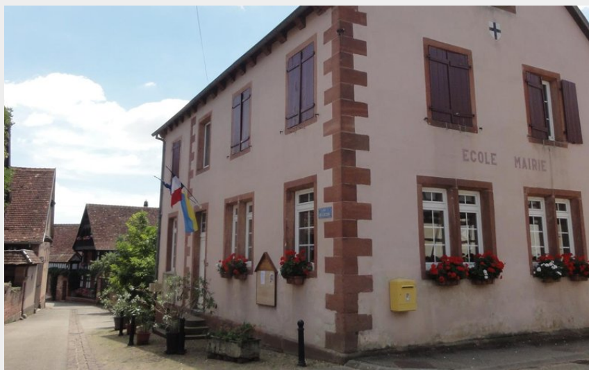
Crédit photo : mairie de Bosselshausen
